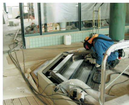
Kuva 46. Rakenteilla oleva teräsallas.
