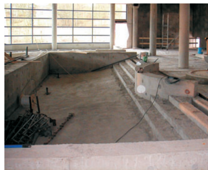
Kuva 45. Rakenteilla oleva betoniallas.
