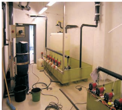
Kuva 69. Kemikaliointilaitteisto.
