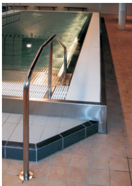
Kuva 61. Allasritiläkulma.
