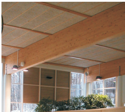
Kuva 51. Lastusementilevyä alakattorakenteessa.
